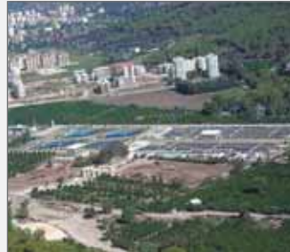
Antalya Hurma Atık Su Arıtma Tesisi
